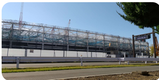
【建設中のスマート工場】
